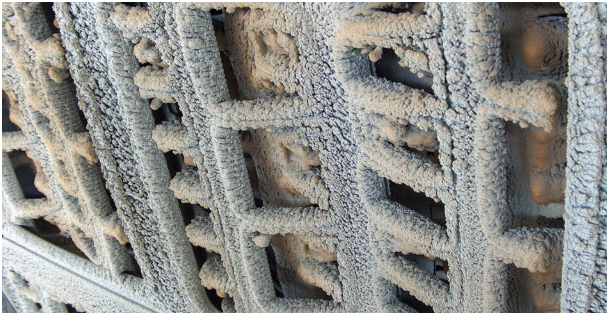
Ondanks grote verfofname behoudt het Edrizzi systeem bijzonder lang een open structuur.
