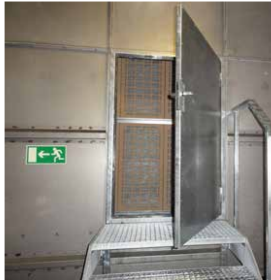
Step6 - Abgeschlossener Umbau: Rückseitige Tür zum Unterdruckraum.
