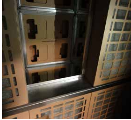
Step4 - Umbauphase: Rückseitige Ansicht der voll bestückten edrizzi® Farbnebelabscheidewand mit VARIO und Nachfilterung NFEWP03.
