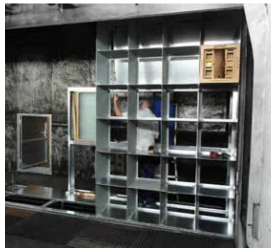
Step2 - Umbauphase: Aufbau der Einschubelemente für die edrizzi® Farbnebelabscheider und die Nachfilterung NFEWP03.
