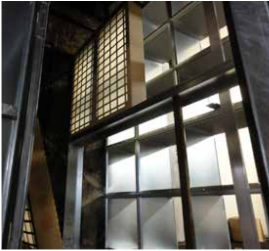
Step3 - Umbauphase: Rückseitige Ansicht der edrizzi® Farbnebelabscheidewand mit Nachfilterung NFEWP03.
