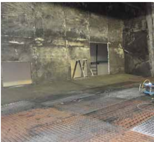
Step1 - Umbauphase: Die Wasserwand wird entfernt, der Unterdruckraum freigelegt.
