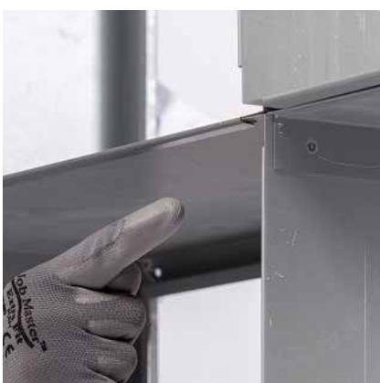
**Step6:** Achten Sie beim Aufbau auf die richtige Position der Fälze, um die Elemente zu einer Wand zusammenzufügen.
