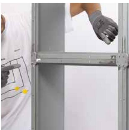
**Step8:** An jeder Kante von vier Einschubelementen werden die Knotenbleche zur Fixierung verwendet. Fachgerechtes Verschweißen direkt im Knotenbereich ist ebenfalls möglich.
