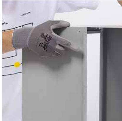
**Step1:** Anzahl der Einschubelemente vorbereiten: Diese so ausrichten, dass sich die Fälze der einzelnen Einschubelemente jeweils immer unten und an der gleichen Seite links oder rechts befinden – je nach „Startseite“ des Einbaus.
