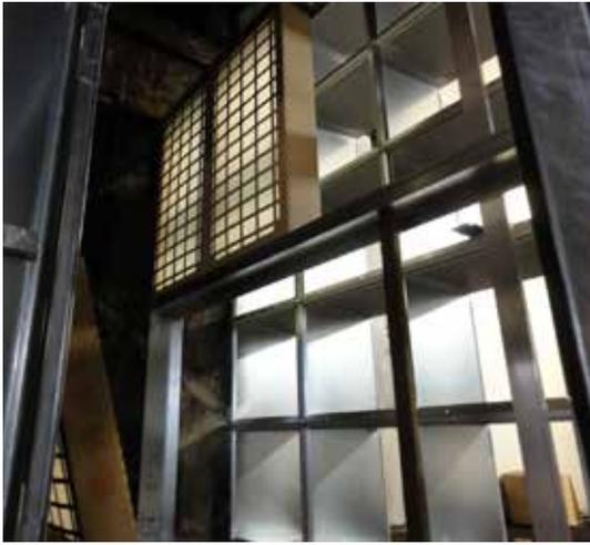
Step3 - Umbauphase: Rückseitige Ansicht der edrizzi® Farbnebelabscheidewand mit Nachfilterung NFEWP03.
