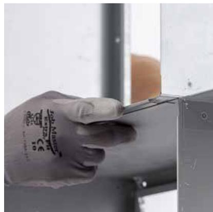
**Step4:** Beginnen Sie nun den vertikalen Aufbau und setzen Sie auf die erste Reihe Einschubelemente weitere.
