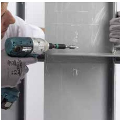
**Step7:** Die Einschubelemente werden von innen nach außen mit Selbstbohrschrauben über das Knotenblech verbunden.
