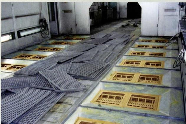
Der Austausch einer Venturi-Nassauswaschung gegen eine Edrizzi-Trockenabscheidung ist in nur wenigen Tagen möglich
