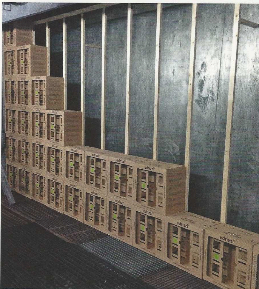
Schnell und kostengünstig gezimmerte Verstrebenen, in diesem Fall aus Holz, dienen als provisorische Abscheidewand für den Testlauf. Natürlich können auch Baustahlgitter oder eine Formrohrkonstruktion verwendet werden. Beim professionellen Umbau dienen Einschubelemente aus Blech, die im Baukastensystem zusammengesetzt werden, als Stützkonstruktion für die Abscheideboxen.
